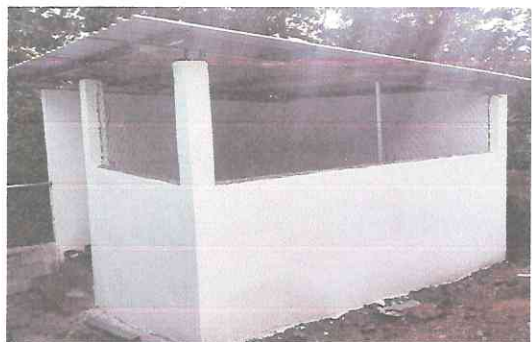
Imagen de cocina de 3 metros cuadrados con techo de lámina troquelada con estructura metálica.
