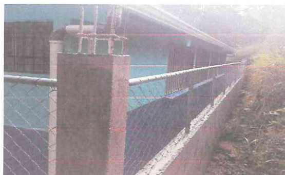
Muro perimetral con malla galvanizada tensada con tubo hg
