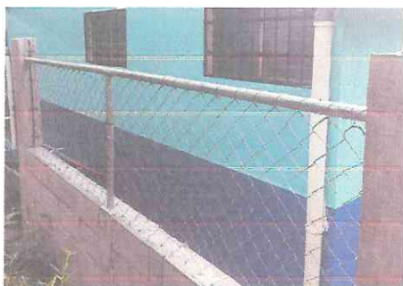
Muro perimetral con malla galvanizada tensada con tubo hg
